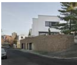
S RODINNÝ DVOJDŮM SEMI-DETACHED HOUSE PRAHA—BRANÍK T NOVOSTAVBA NEW CONSTRUCTION R 2014—2016 P 10/2012—06/2013 119 M 2 I SOUKROMÁ OSOBA PRIVATE INVESTOR D SUBDODAVATELSKY SUBCONTRACTED
