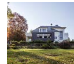
S REKONSTRUKCE PRVOREPUBLIKOVÉ VILY RECONSTRUCTION OF FIRST REPUBLIC VILLA KOCHÁNOV T REKONSTRUKCE RECONSTRUCTION R 11/2016—09/2017 P 02/2016 248 M 2 I SOUKROMÁ OSOBA PRIVATE INVESTOR D CHLÁDEK A TINTĚRA A.S. HAVLÍČKŮV BROD
