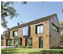
S RODINNÝ DŮM U ŽELEZNÝCH HOR FAMILY HOUSE NEAR ŽELEZNÉ HORY CHOTĚBOŘ T NOVOSTAVBA NEW CONSTRUCTION R 06/2012—2016 P 01/2011—02/2012 150 M 2 I SOUKROMÁ OSOBA PRIVATE INVESTOR D SUBDODAVATELSKY SUBCONTRACTED
