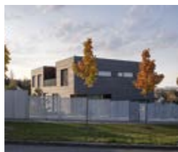
S RODINNÝ DŮM CÍPEK CÍPEK FAMILY HOUSE HUMPOLEC T NOVOSTAVBA NEW CONSTRUCTION R 06/2011—11/2016 P 03/2010—05/2011 243 M 2 I SOUKROMÁ OSOBA PRIVATE INVESTOR D JN—STAVBA S.R.O. HUMPOLEC
